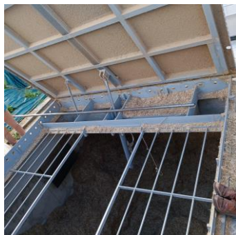
Silo et chaudière bois/miscanthus qui alimente l'école et la mairie en chauffage
