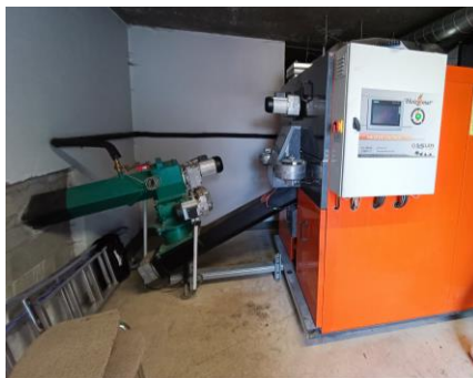
Silo et chaudière bois/miscanthus qui alimente l'école et la mairie en chauffage
